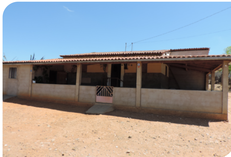
Casa 59, – distante 1,2 km do aerogerador A31
