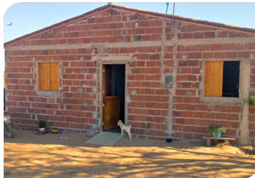
Casa 21, – distante 20 metros para o acesso externo – comunidade de Sítio do Meio/ Lagoa do Barro do Piauí – PI.
