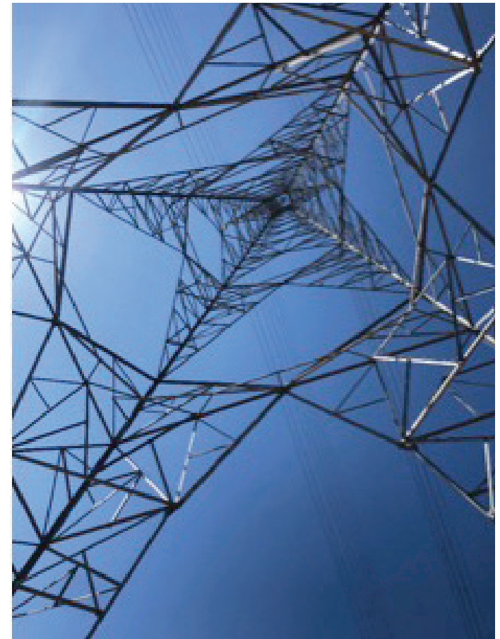
Vista interna de uma torre autoportante
