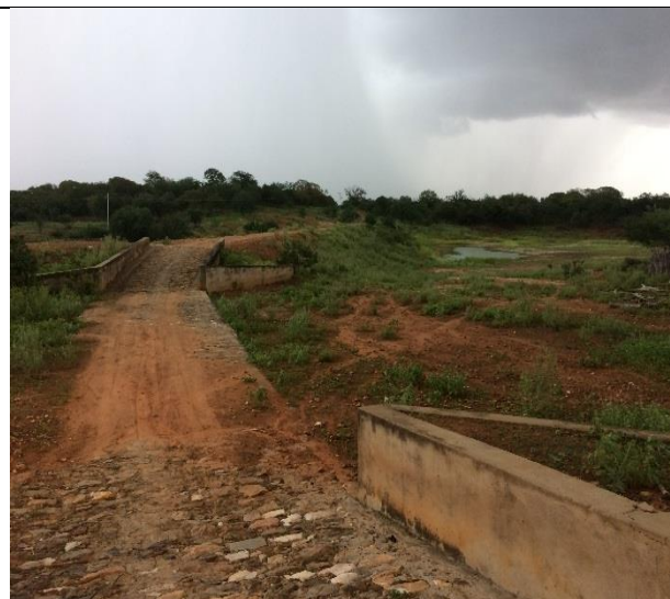
Via de acesso à comunidade Morro Alto, com infraestrutura de pontilhões.
