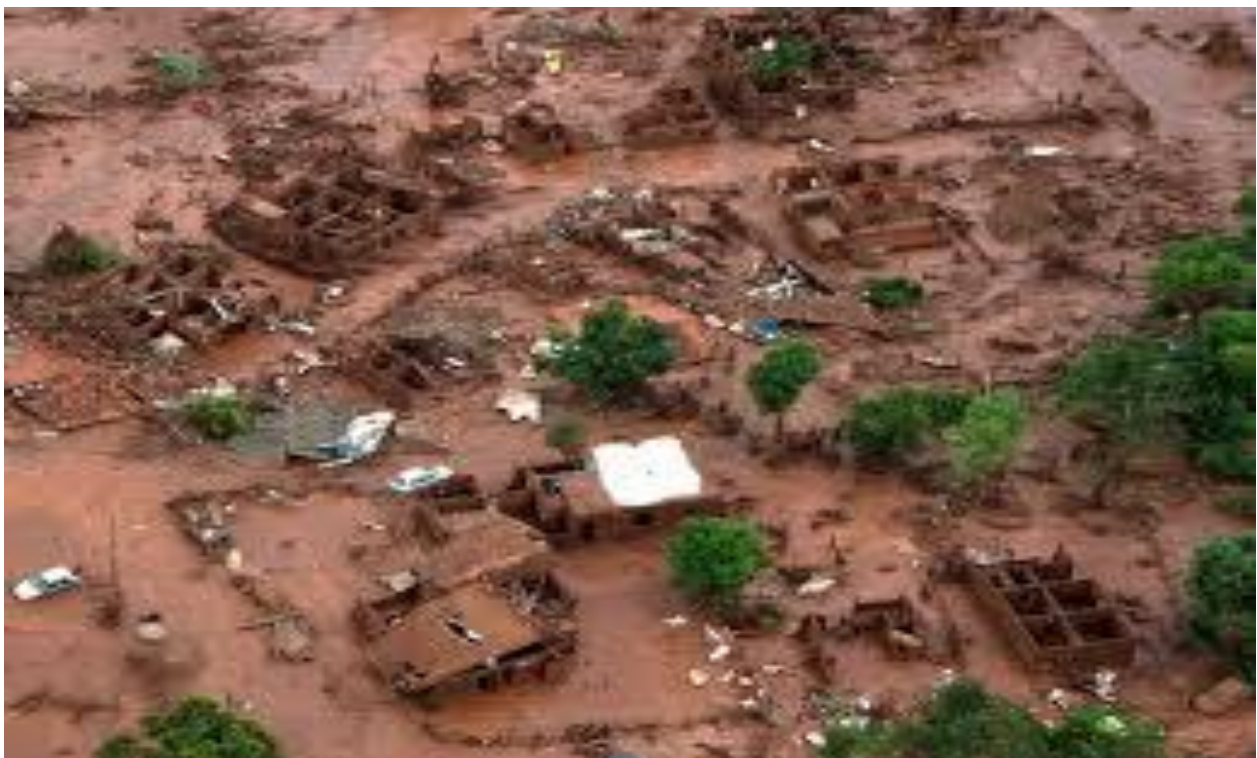
Figura 2: Imagem pós rompimento da Barragem Mariana em Minas Gerais em 2019.
