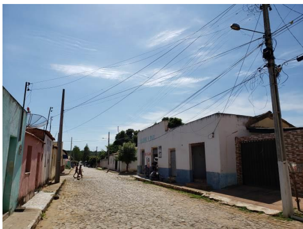
Foto 3.36 – Via principal do centro da sede de Tamboril do Piauí, pavimentada em paralelepípedo. Foto: GEOCONSULT SOLUÇÕES AMBIENTAIS (2020).
