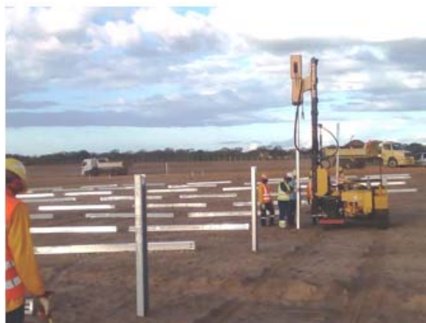
Figura 2.12 - Fundação com Hastes Cravadas
