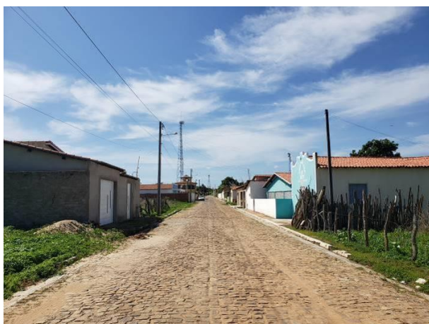
Foto 3.26 – Vista de uma via de acesso secundário pavimentada na sede urbana de Brejo do Piauí. Foto: GEOCONSULT SOLUÇÕES AMBIENTAIS (2020).
