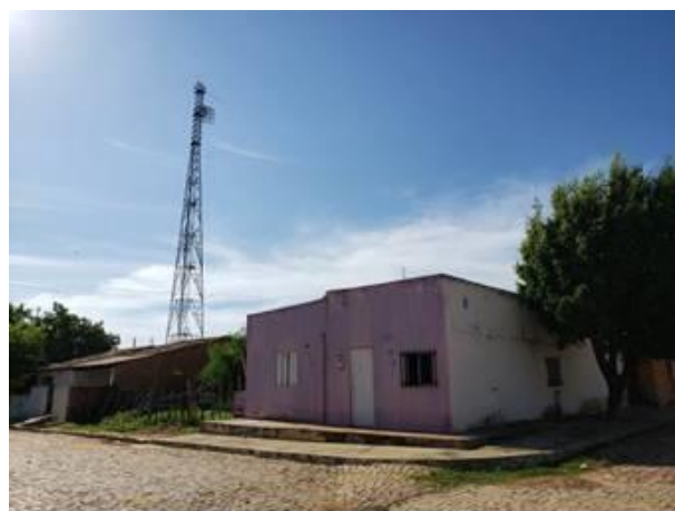
Foto 3.35 Antena de transmissão de sinal telefonia móvel instalada na sede urbana de Tamboril do Piauí. Foto: GEOCONSULT SOLUÇÕES AMBIENTAIS (2020).
