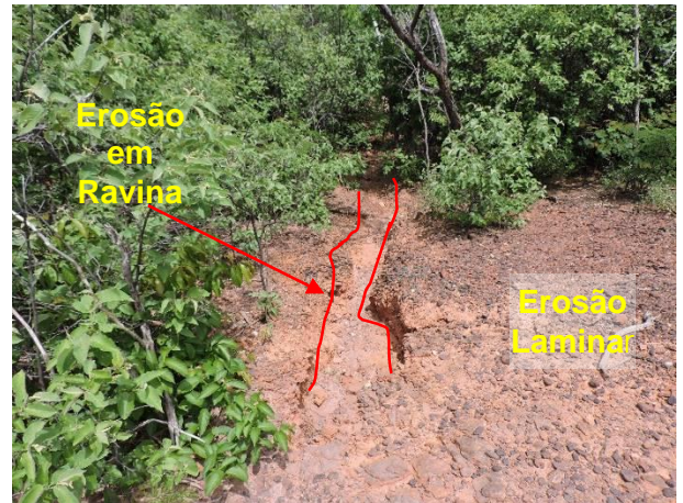
Foto 3.14 – Processos erosivos identificados nas áreas de influência do estudo ambiental. UTM 23 L 732574 E; 9062204 N. Foto: GEOCONSULT SOLUÇÕES AMBIENTAIS (2020).
