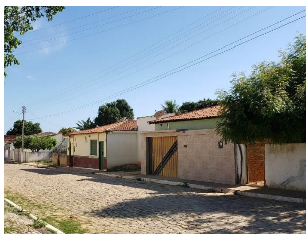
Foto 3.32 – Domicílios residenciais em alvenaria com revestimento na sede urbana de Tamboril do Piauí. Foto: GEOCONSULT SOLUÇÕES AMBIENTAIS (2020).
