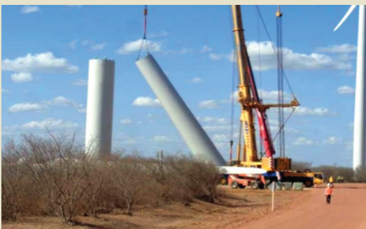
Montagem do segundo seguimento da torre
