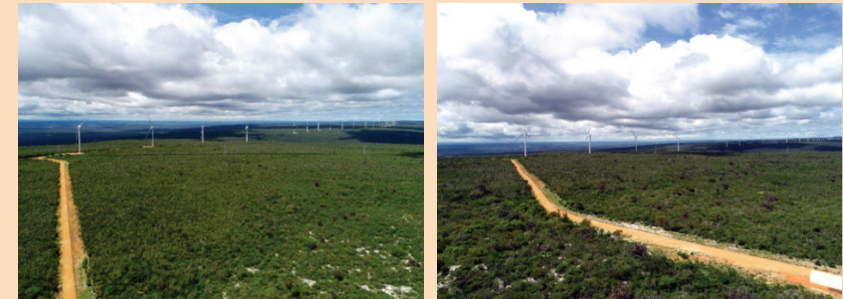
CONSTRUÇÃO DE ACESSOS
