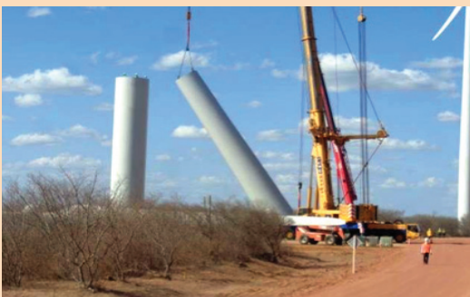
Montagem do segundo seguimento da torre
