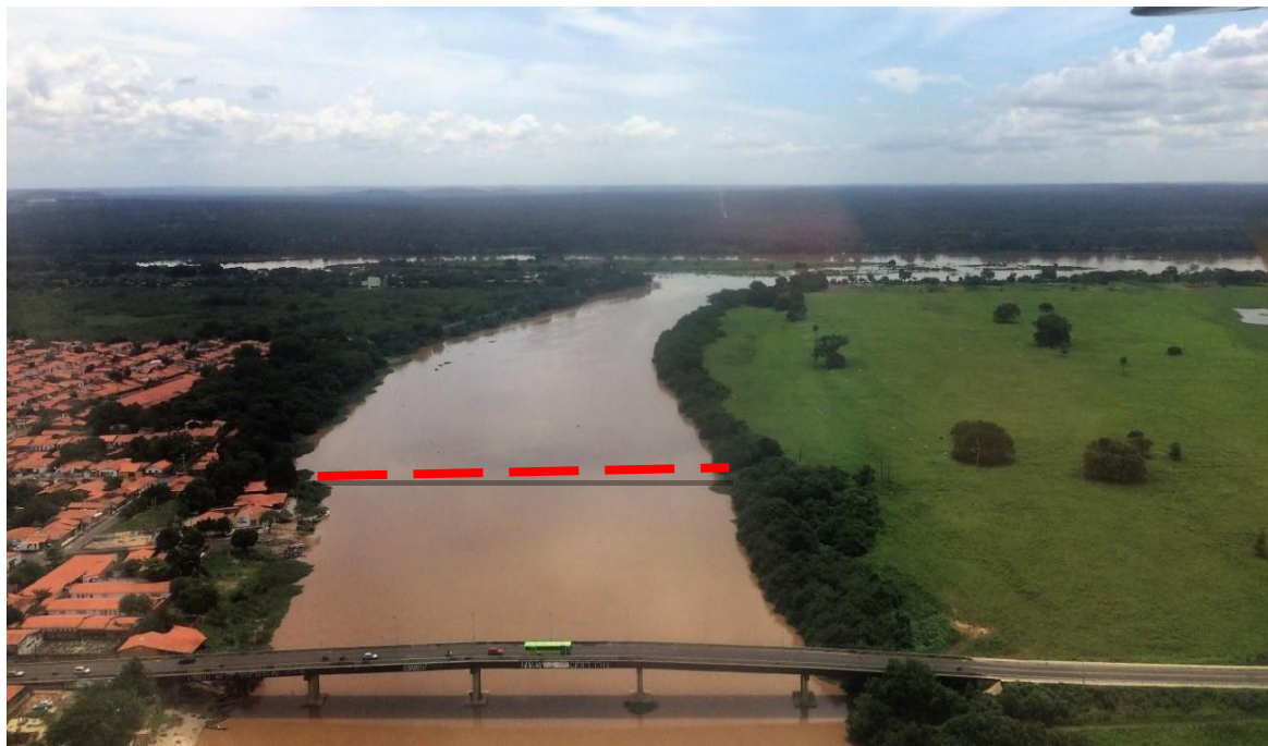
Foto 8.2 - Imagem aérea do rio Poti na área de intervenção da obra
