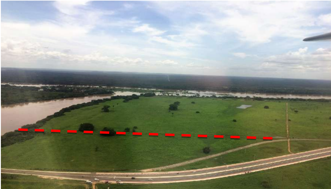
Foto 8.21 - Imagem aérea da área onde será construído o acesso à ponte
