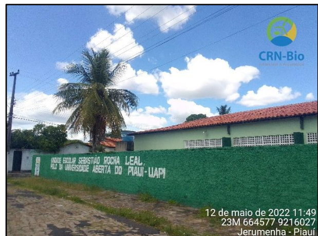
Figura 7.38: Unidade Escolar Sebastião Rocha Leal, sede de Jerumenha. Fonte: CRN-Bio, 2022.
