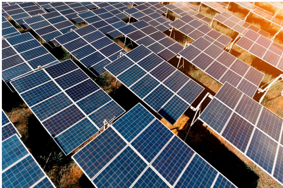
Figura 4.2: Instalação de módulos fotovoltaicos.
