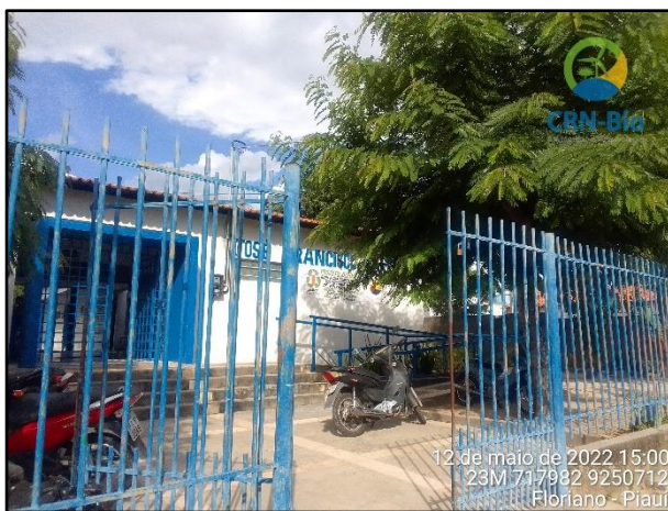
Figura 7.35: Escola Municipal José Francisco Dutra, sede de Floriano. Fonte: CRN-Bio, 2022.
