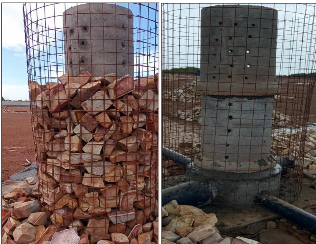
Figura 11.0 - Modelo de Sistema de Drenagem de Biogás
