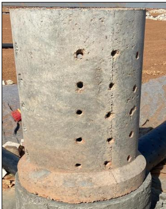
Figura 12.0 - Modelo de Sistema de Drenagem de Biogás
