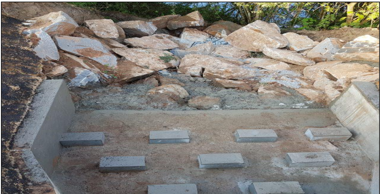
Figura 26.0 - Exemplo de bacia de enrocamento.
