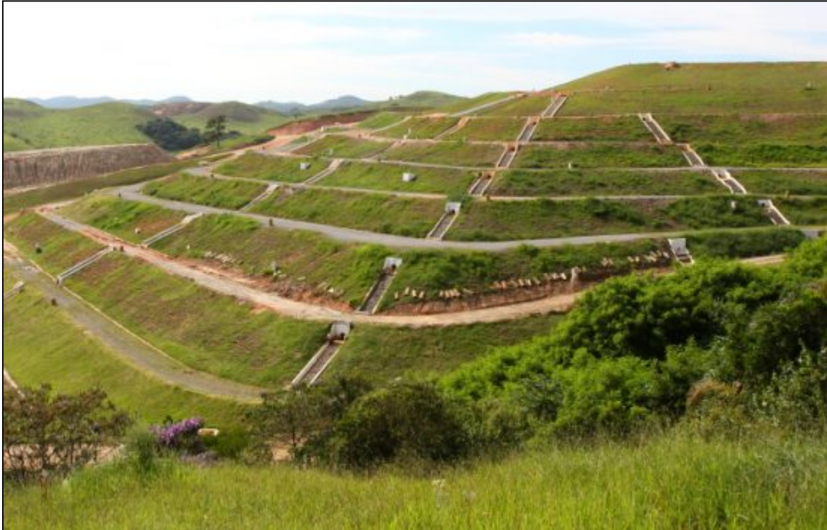
Figura 27.0 - Exemplo de Aterro Encerrado.
