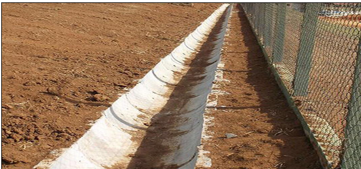
Figura 21.0 - Exemplo de canaletas de concreto tipo meia-cana.
